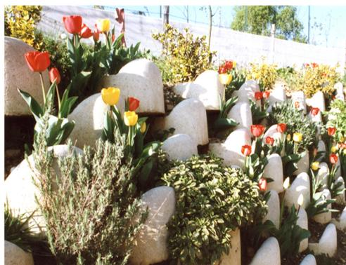
Le mur ATALUS est un véritable système de soutènement alvéolaire végétalisable. Les blocs de forme circulaire permettent d'appréhender tous les types d'angles et de courbes possibles. Les éléments sont espacés entre eux de manière à laisser filtrer l'eau. Le poids de chaque élément ainsi que le coefficient de friction du béton assurent la cohésion entre les éléments.
