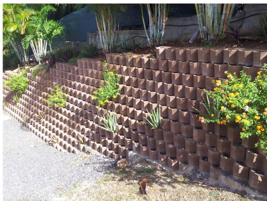
Les éléments sont bloqués entre eux sans vide intermédiaire, grâce à un système de crabots breveté. La terre emplissant les alvéoles ne peut s'évacuer sur l'extérieur.
